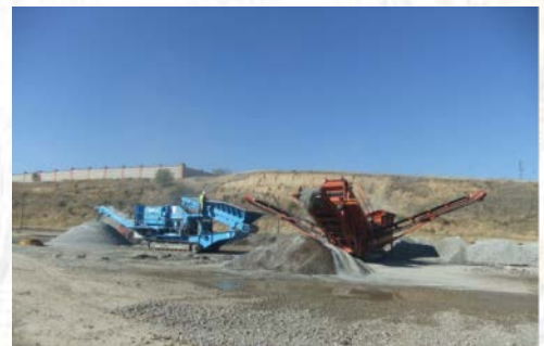
Instalación de planta de machaqueo en obra
