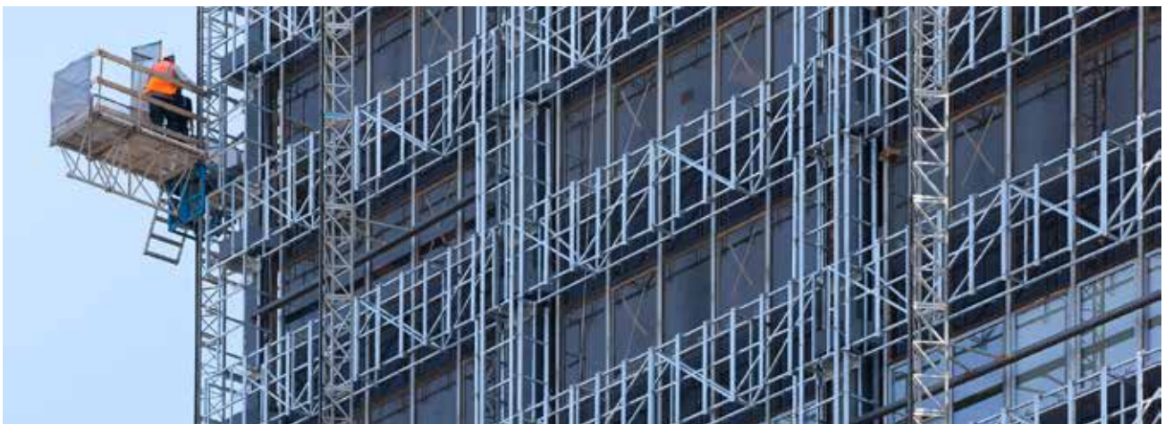
Rehabilitación energética. Málaga (España)
