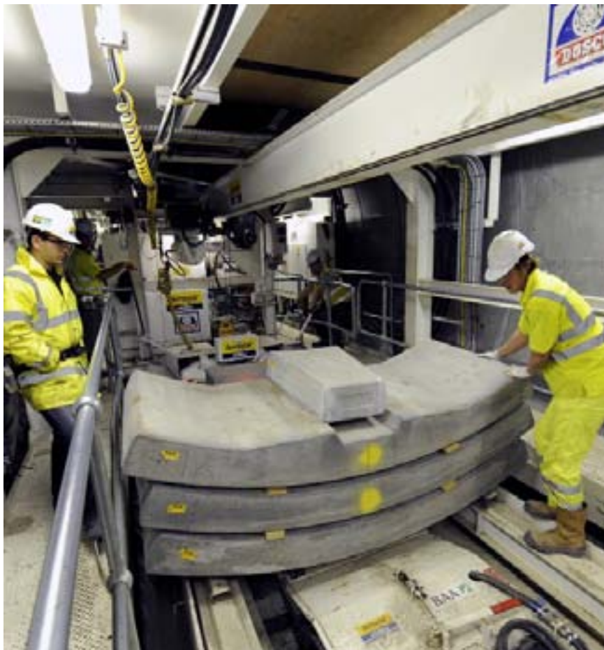
Operarios de Ferrovial Agromán en las obras del nuevo túnel de equipajes del aeropuerto de Heathrow
