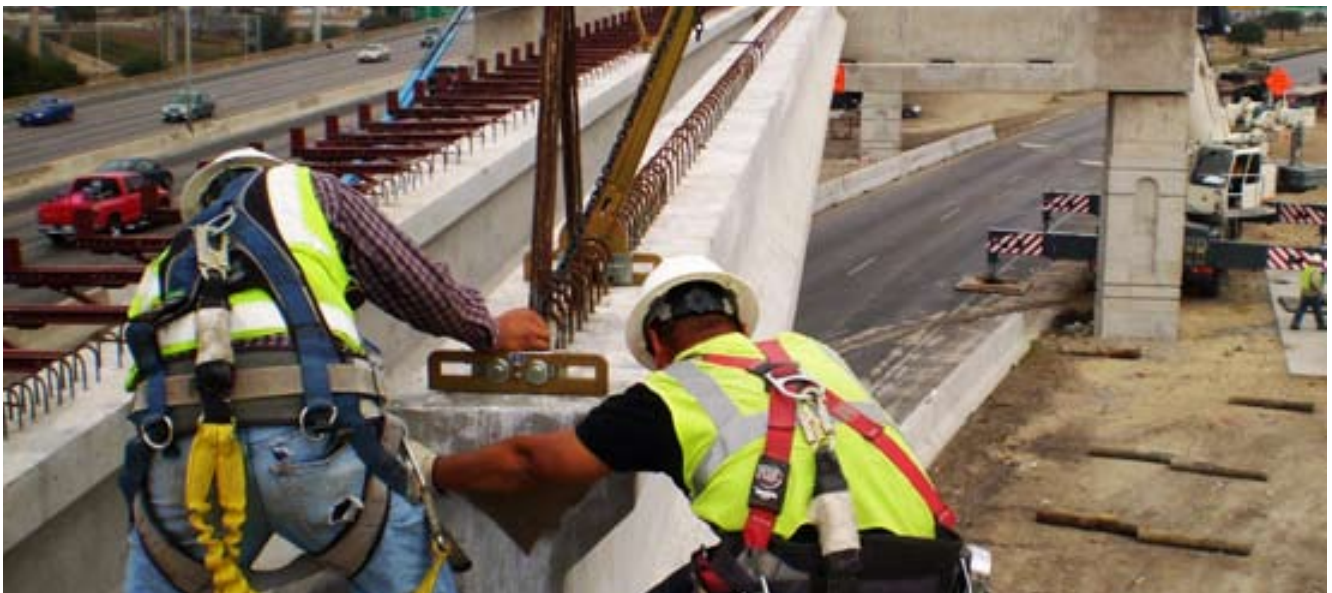
Trabajos en las obras de la IH-35 en su paso por San Antonio-Bexar County (Texas, EEUU)
