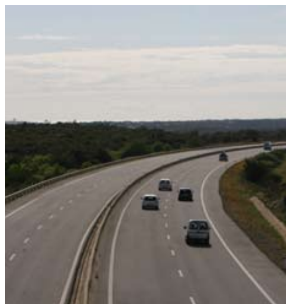
Autopista Euroscut Algarve (Algarve, Portugal)
