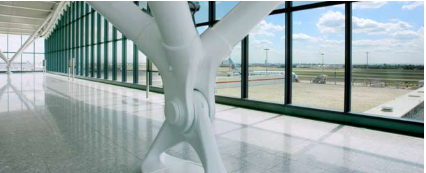
Terminal 5 del aeropuerto de Heathrow (Londres, Reino Unido)
