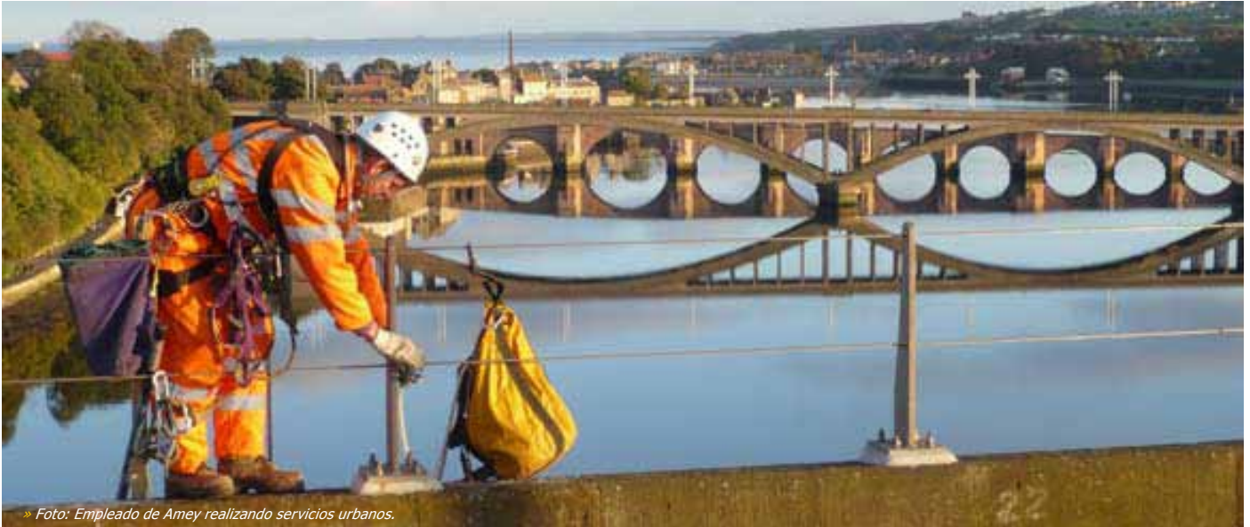
» Foto: Empleado de Amey realizando servicios urbanos.
