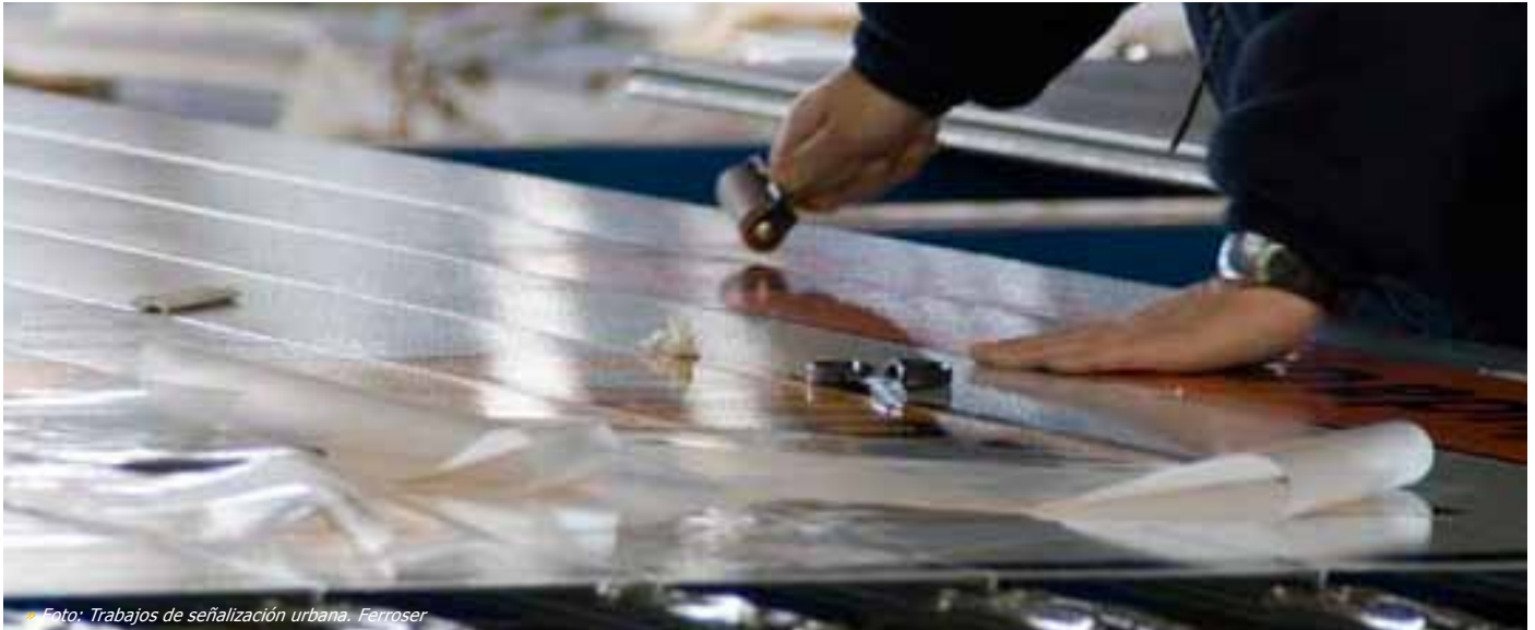
• Foto: Trabajos de señalización urbana. Ferroseser
