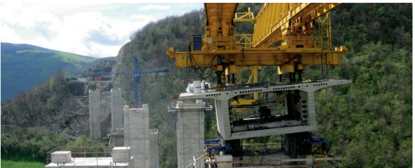
Autovía Cantabria - La Meseta (España)
