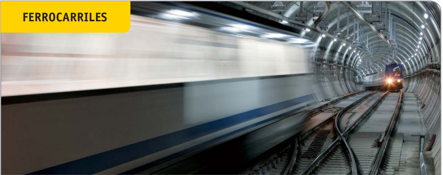
Prolongación línea 5 del Metro de Madrid (España)
