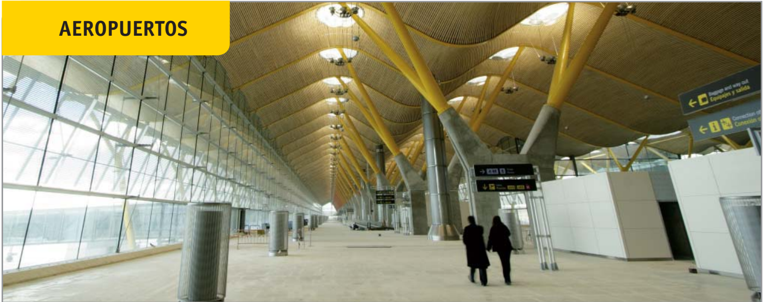
Terminal 4. Aeropuerto de Barajas (Madrid, España)
