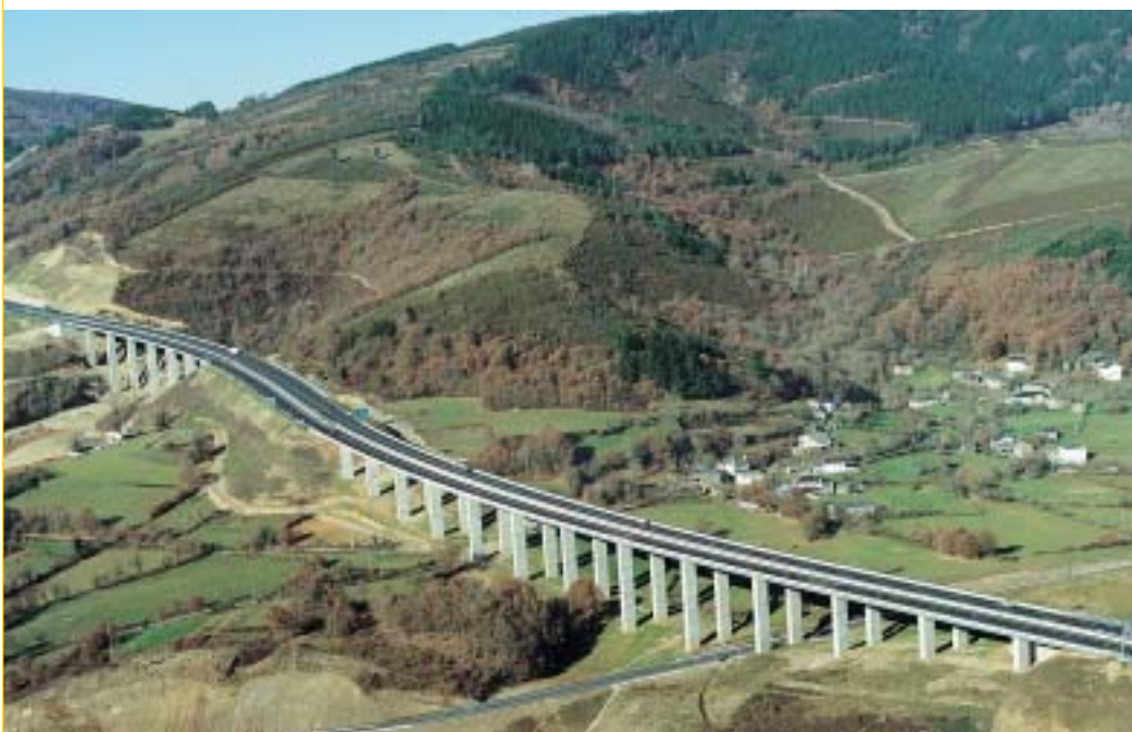
Autovía del Noroeste. CN-VI de Madrid a A Coruña
