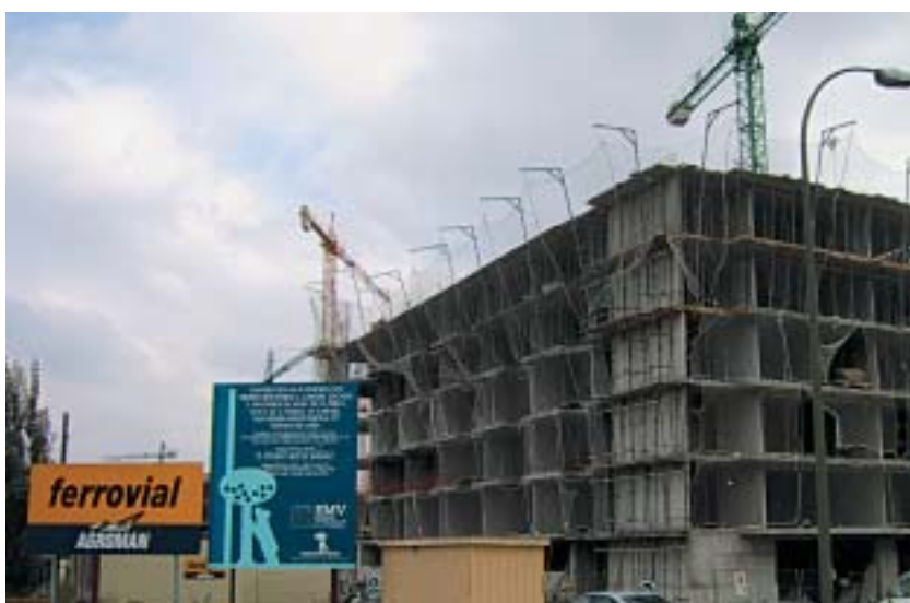
Edificio de VPO en Madrid, ejecutado por Ferrovial para la EMV
