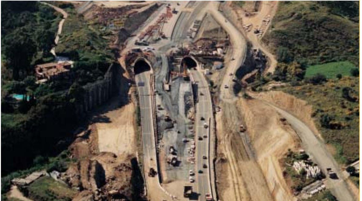
Autopista de la Costa del Sol, entre Málaga y Estepona
