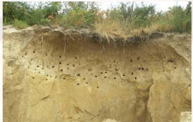
Colonia de avión zapador en desmonte de la obra AVE Rialíño-Padrón
