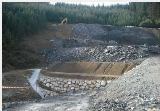
Ejecución del nuevo encauzamiento junto al vertedero de tierras en uso
