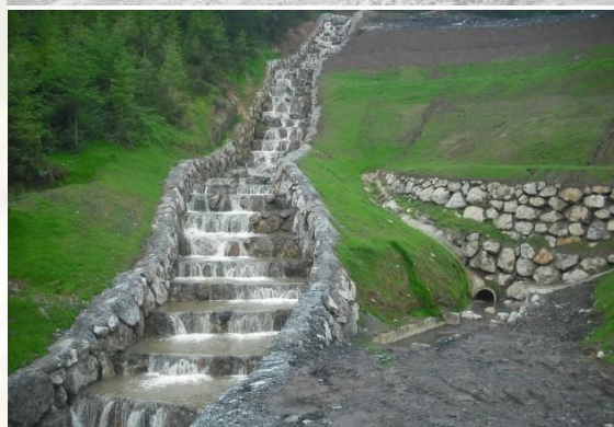
Situación final del nuevo cauce, mediante bajante escalonada
