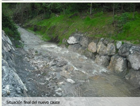
Situación final del nuevo cauce, mediante bajante escalonada
