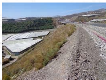
Taludes restaurados con vegetación autóctona
