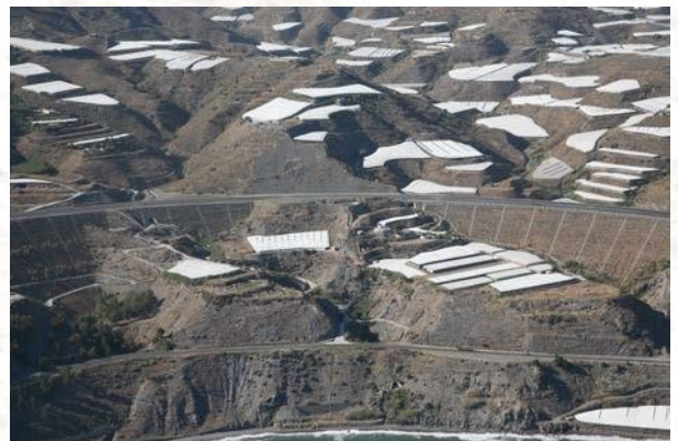
Vista general de la zona de obras
