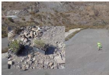
Trabajos de plantación (detalle de esquejes)
