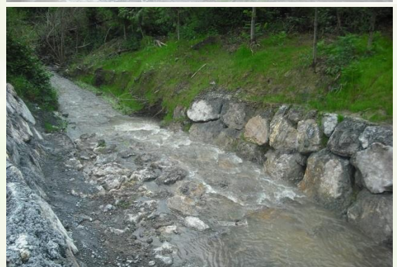
Situación final del nuevo cauce
