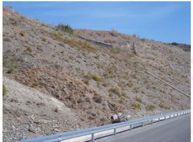
Desmonte en proceso de recuperación
