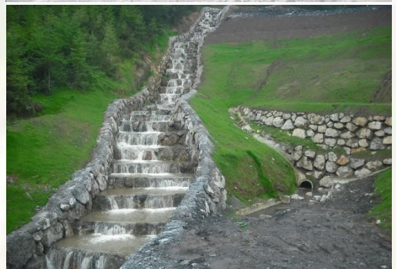
Situación final del nuevo cauce, mediante bajante escalonada
