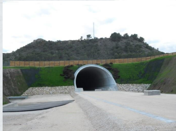
Trabajos de estabilización de emboquille de túnel
