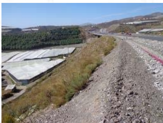
Taludes restaurados con vegetación autóctona
