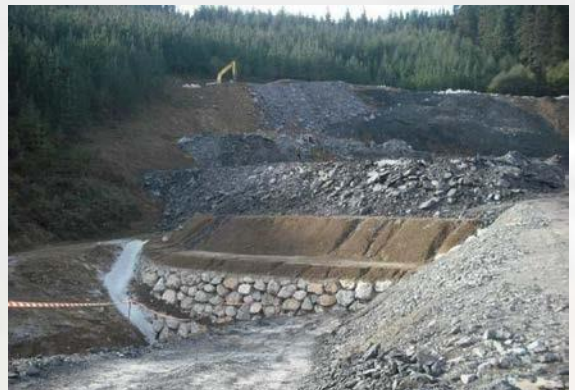
Ejecución del nuevo encauzamiento junto al vertedero de tierras en uso
